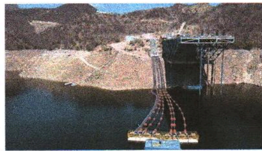
Figura 19. Vista aérea rebombeo de sistema de bombeo flotante en Obra de toma del Acueducto Independencia. Fuente propia.
