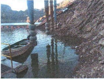
Figura 18. Imágenes de las bombas de Obra de toma fija, al momento del arranque del sistema de bombeo flotante. Fuente: Elaboración propia.
